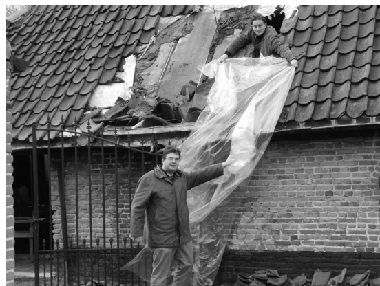
Het dak van de Kiekenhoeveschuur
